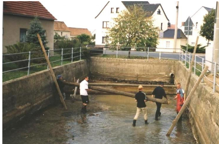
Baumaßnahmen am ehemaligen Dorfteich
