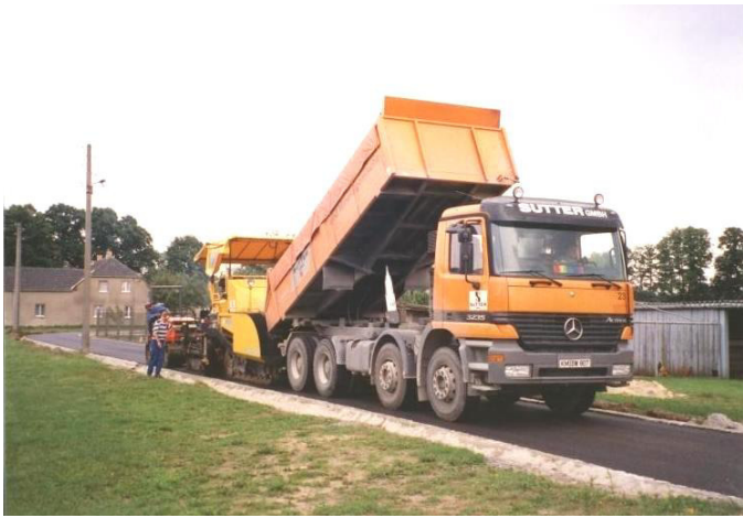
Zweiter Bauabschnitt des Ausbaus der Fabrikstraße
