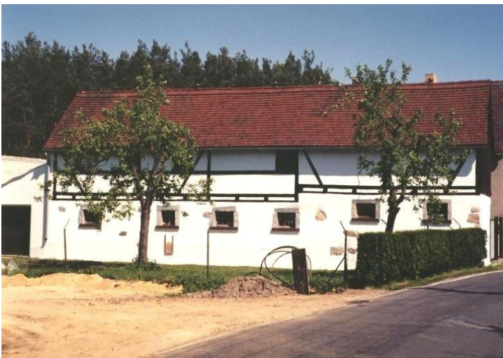
Sanierte Scheune auf der Wittichenauer Straße
