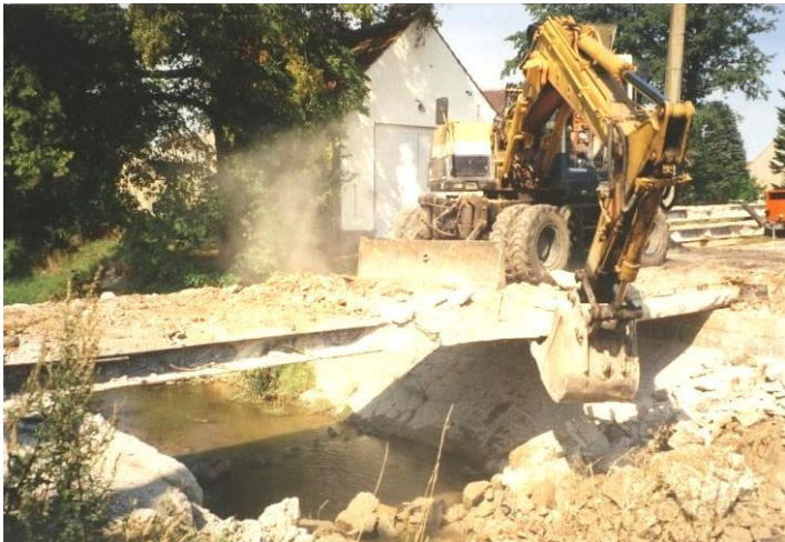
Abriss der alten Brücke über das Klosterwasser
