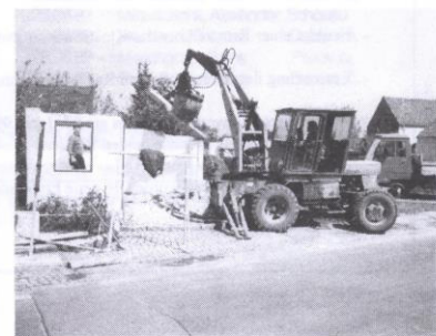
Abriß alter Buswartehäuschen
