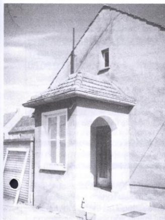
Zachod do Smjerdžečan kulturneho domu do přitwara sanitarnego trakta
